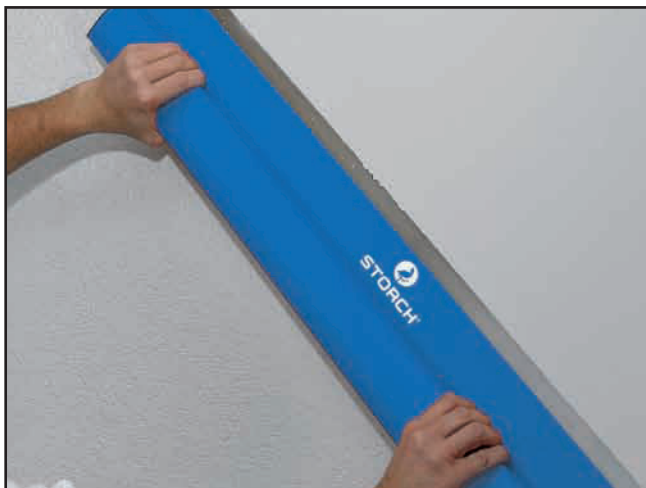
Úsporné stěrkování stříkaných omítek a tmelů.
