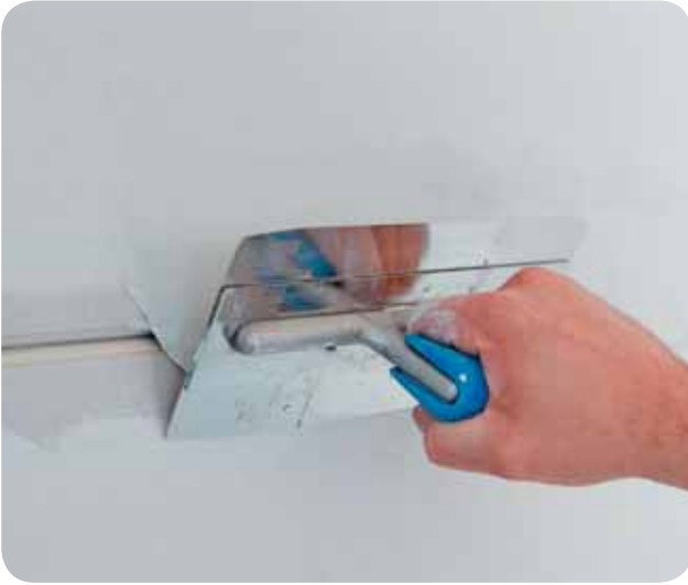
Příčnou spáru vyplníme sádrovým tmelem...
