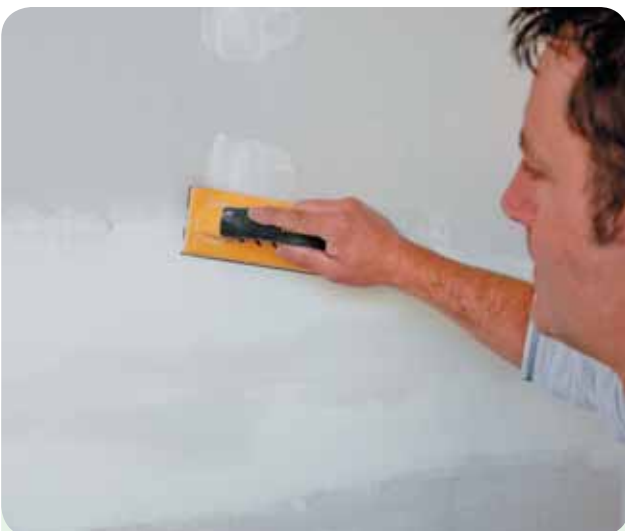
Spáry po zaschnutí následně přebrousíme smirkovou mřížkou.
