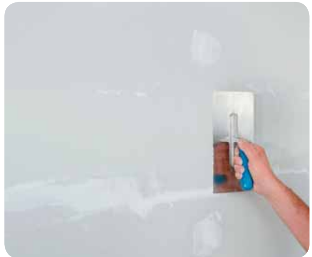
Po zaschnutí první vrstvy tmelu se spáry přestěrkují, hranou hladítka se tmel roztáhne do šířky a uhladí do ztracena. Konečnou úpravu povrchu - finální tmelení - je možno provést např. pastovým (finišovacím) tmelem ProMix Finish (popř. ProMix Mega).
