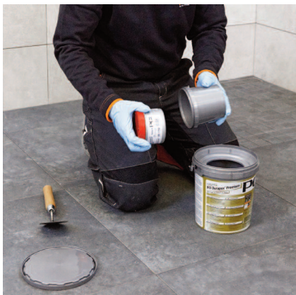
PCI Durapox Premium (2 kg) otevřete a vyjměte druhou složku.
