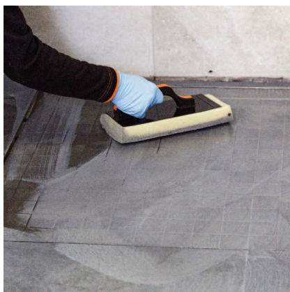
Po 10 - 45 min. plochu zemulgujte pomocí vody a hladítka s vodou.
