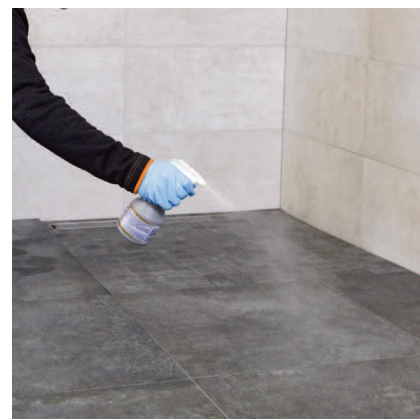
Pro finální mytí po cca 60 min. naneste na plochu PCI Durapox Finish (roztok) pomocí rozprašovače.
