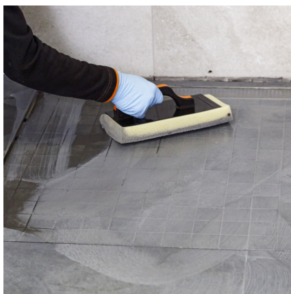
Po 10 - 45 min. plochu zemlujete pomocí vody a hladítka s vodou.
